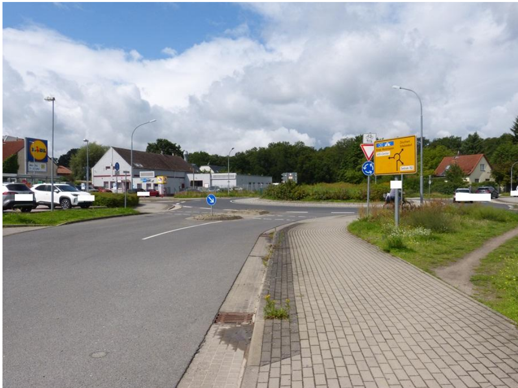
Bild 13: Blick nach Norden entlang der Straße Dorfaue in Richtung Kreisverkehr
