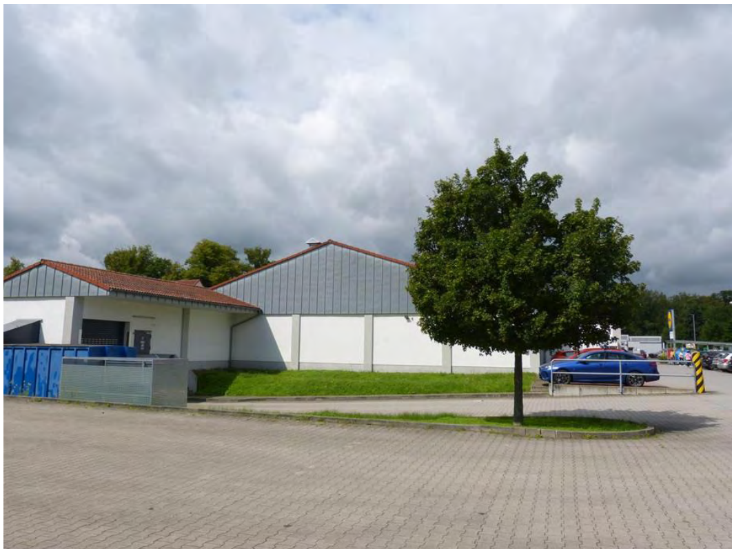
Bild 6: Blick von Osten auf Ostteil des Plangebiets
