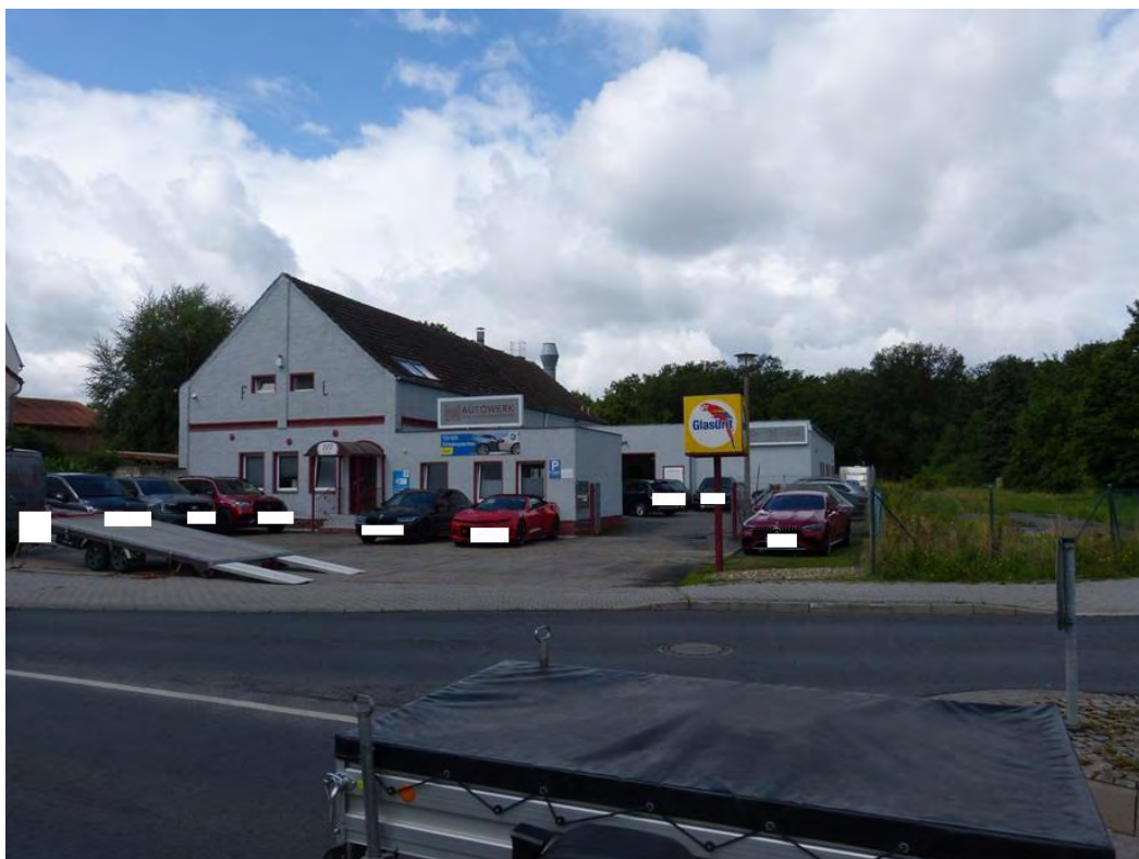
Bild 16: Westlich des Plangebiets befindliche Autowerkstatt
