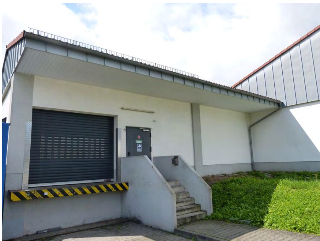
Bild 9: Blick auf den Anlieferbereich des LIDL-Lebensmittelmarktes
