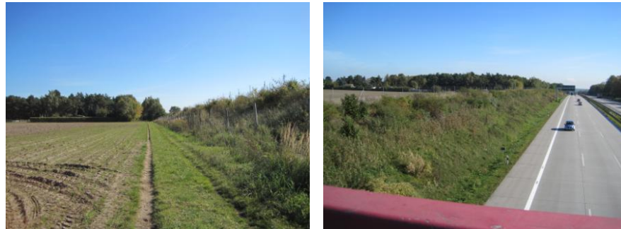
Abbildung 22: Lärmschutzwall (nördlich A10)
