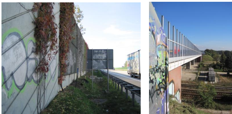
Abbildung 21: Lärmschutzwand (südlich A 10)
