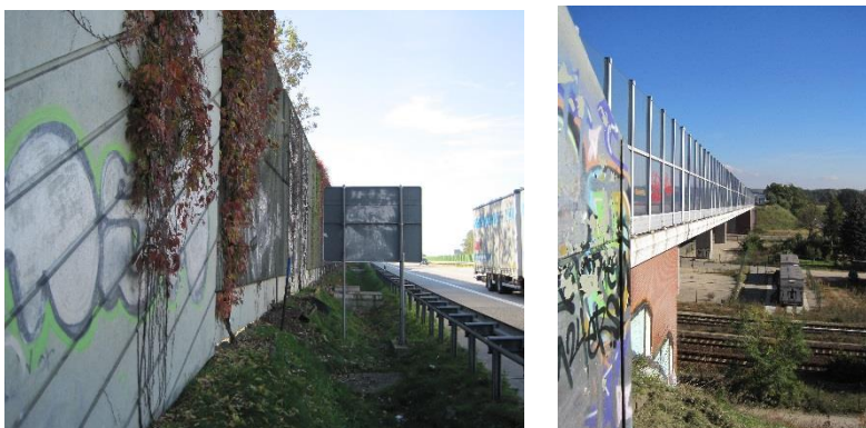
Abbildung 16: Lärmschutzwand (südlich A 10)
