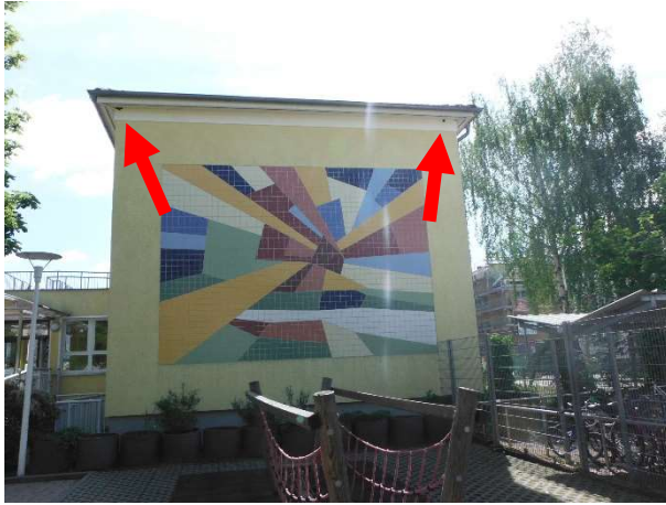
Abb. 13: Hortgebäude mit Löchern am Dachkasten
